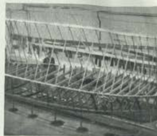
Barre fisse pendenti e sagome di base garantiscono la perfetta uniformità della produzione.
